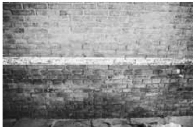
写真6 内部。側壁とアーチで煉瓦積みかたが違う（2005/1）
