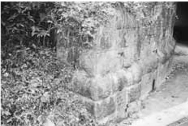
写真5 翼壁状構造物の「隅石」（2004/10、北西から）
