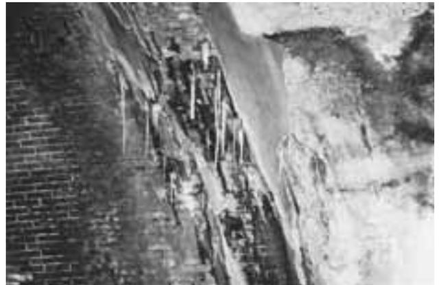
写真12 煉瓦とコンクリートの隙間の氷柱 (2005/1、南東から)
