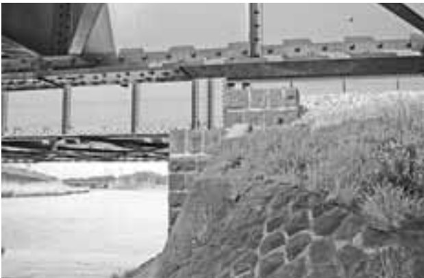
写真26 新井田川橋梁 橋台（南から）
