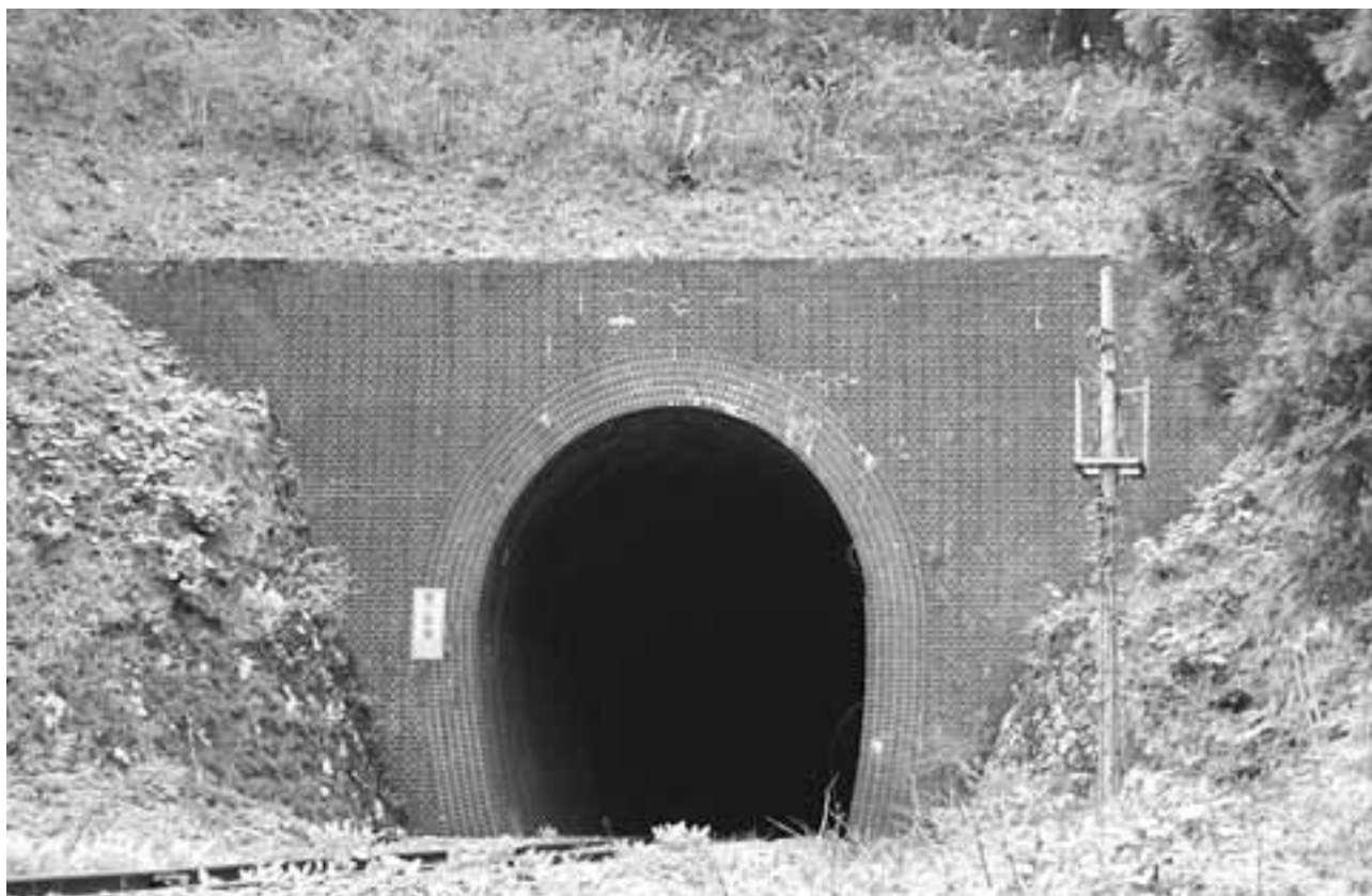
写真8 第二草薙隧道（新庄方）
