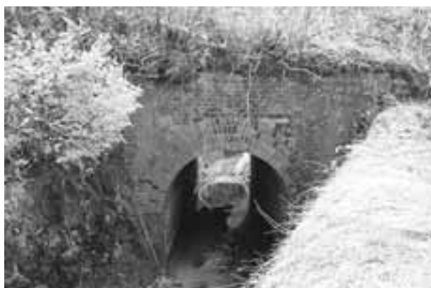
写真11 巻棚橋梁（北から）
