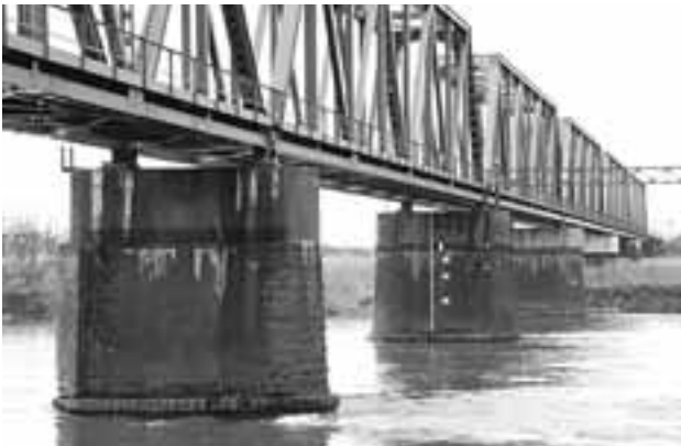
写真24 第二最上川橋梁（上り線）橋脚
