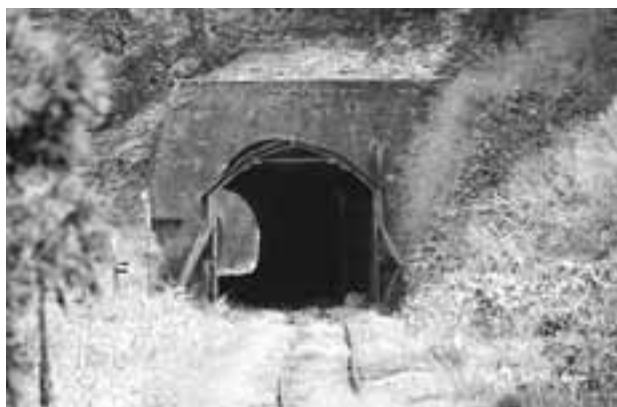
写真7 第二高屋隧道（余目方）雪崩除け付き
