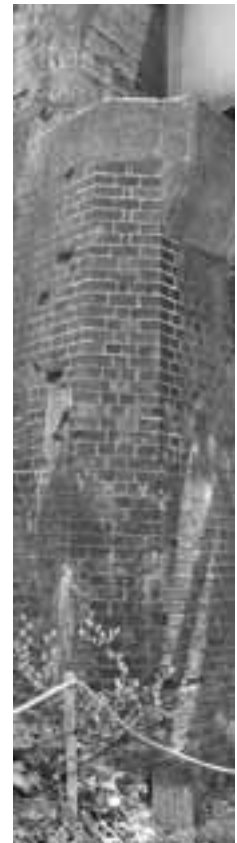
写真32 内又架道橋 橋台 隅部の切り落し面に見られる装飾的な煉瓦積み（左・余目方、右・新庄方）
