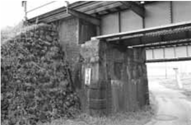
写真22 榎木架道橋（上り線）隅石を有する橋台（新津方）
