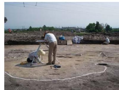
第3図 遺構配置図作成状況（平板測量）
